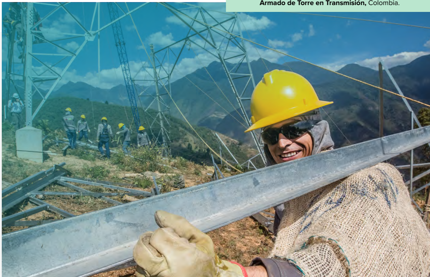
Armado de Torre en Transmisión, Colombia.
