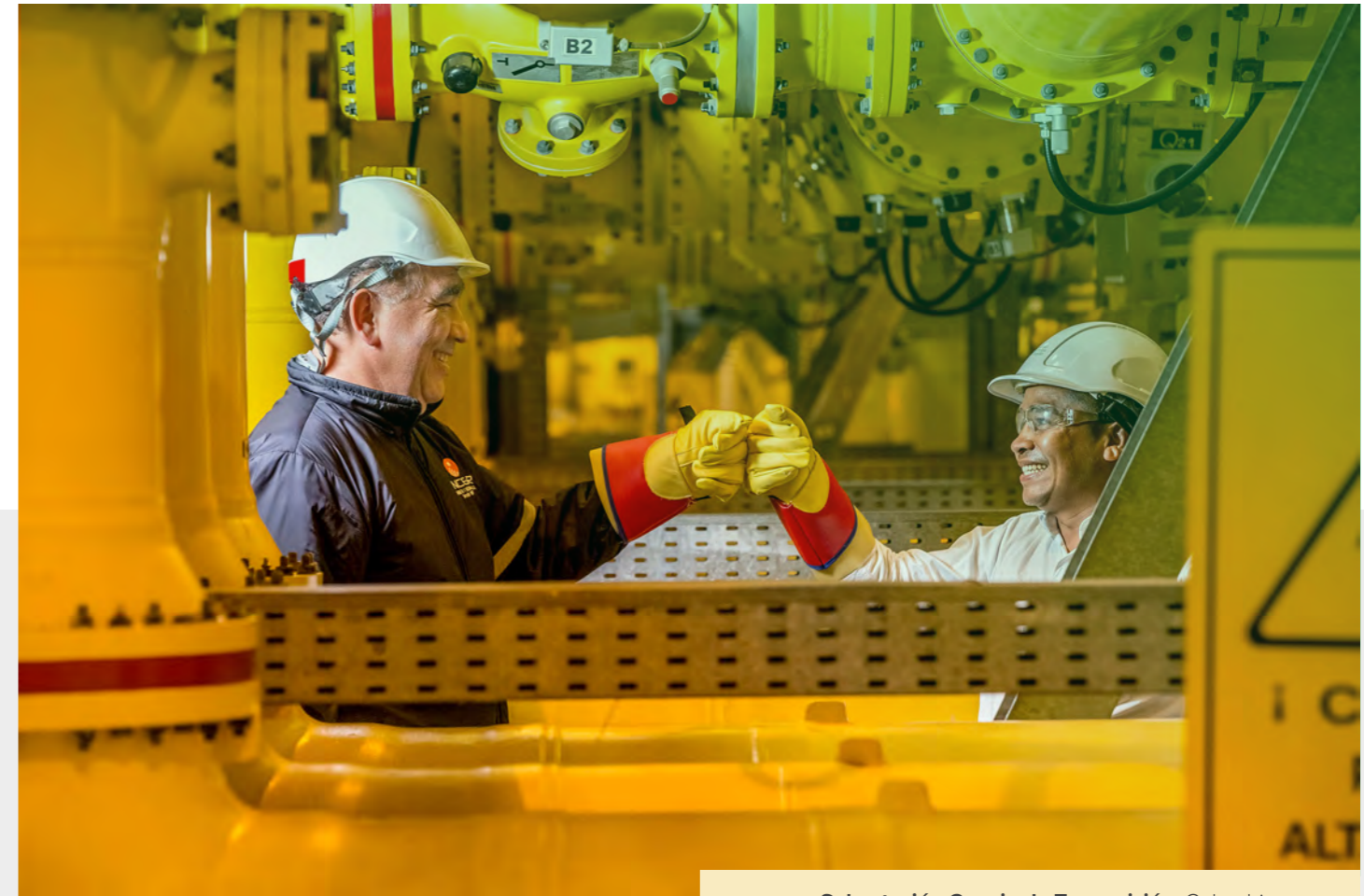
Subestación Guavio de Transmisión, Colombia
