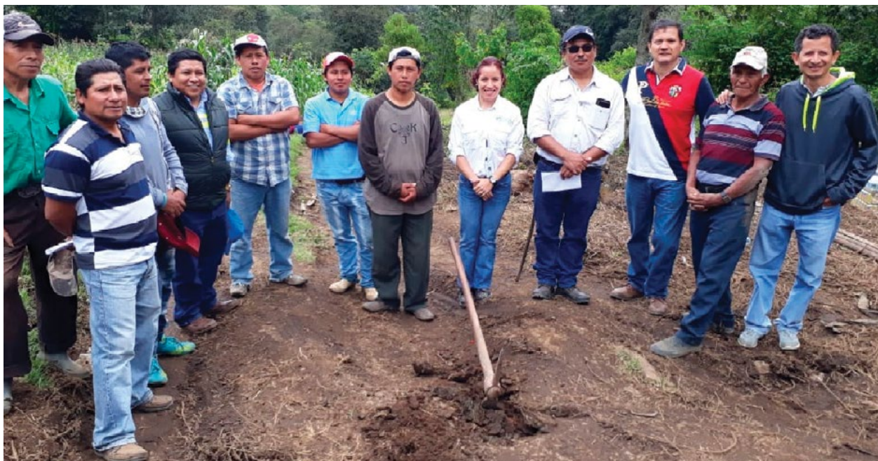
Inicio de trabajos, construcción de carrileras en aldea Paché, Santa María Cauqué, Santiago Sacatepéquez
