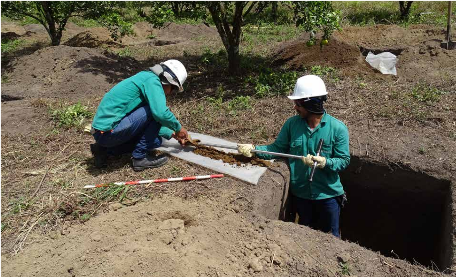
Figura 26. Prueba de barreno para inspeccionar el suelo.
