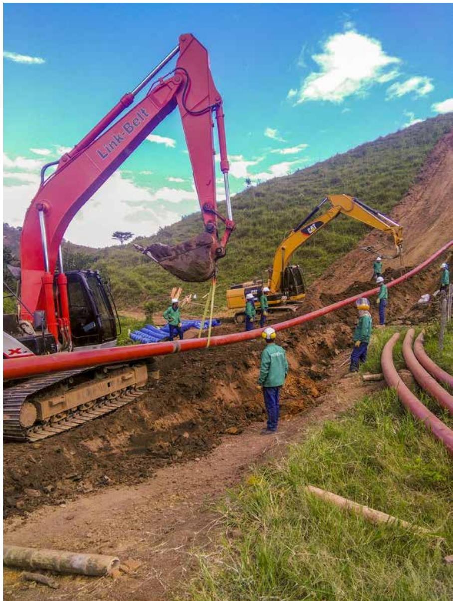
Figura 3. Actividades de construcción del Gasoducto Loop Armenia.
