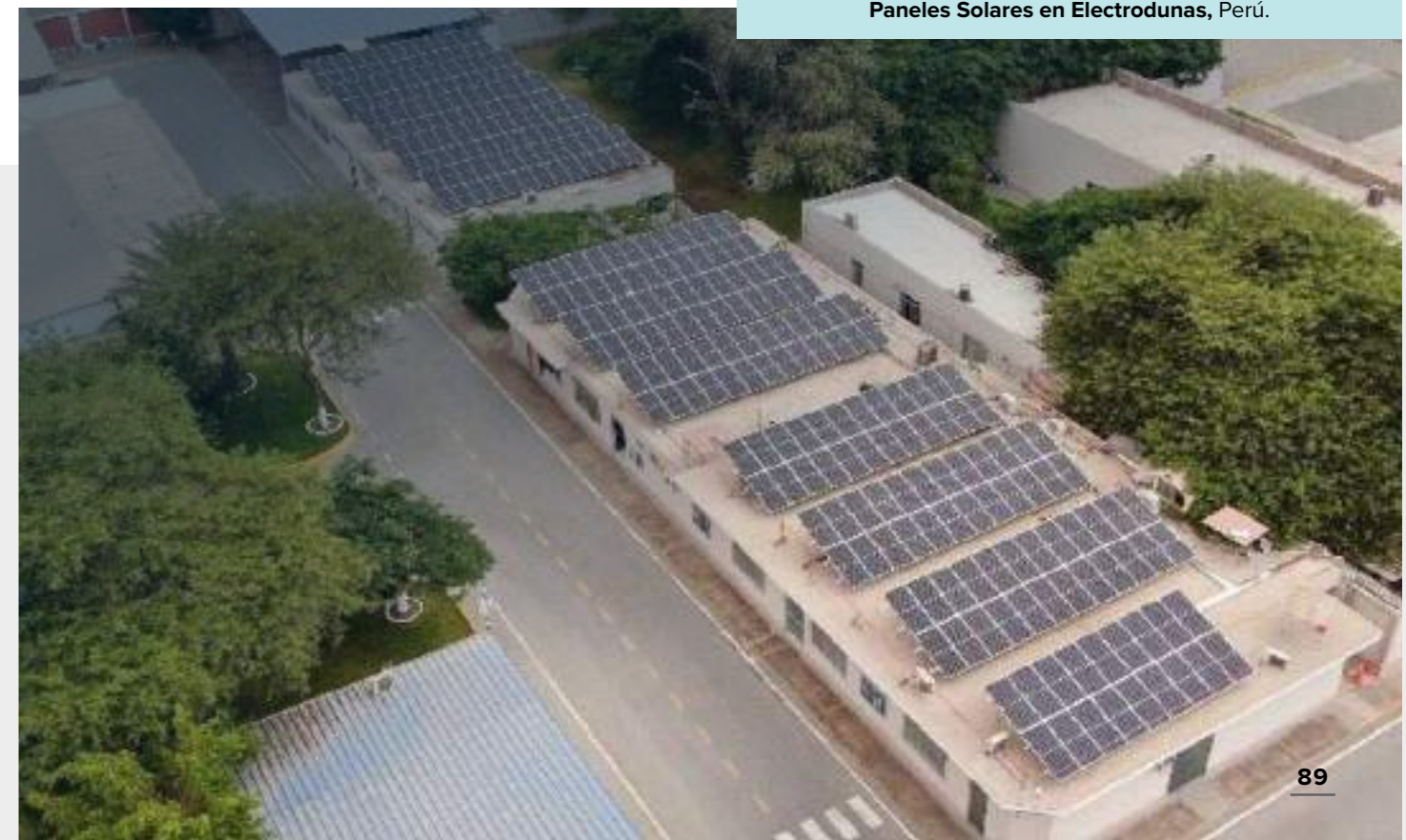
Paneles Solares en Electrodunas, Perú.
