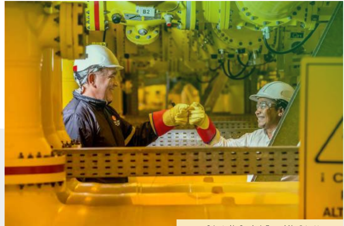
Subestación Guavio de Transmisión, Colombia
