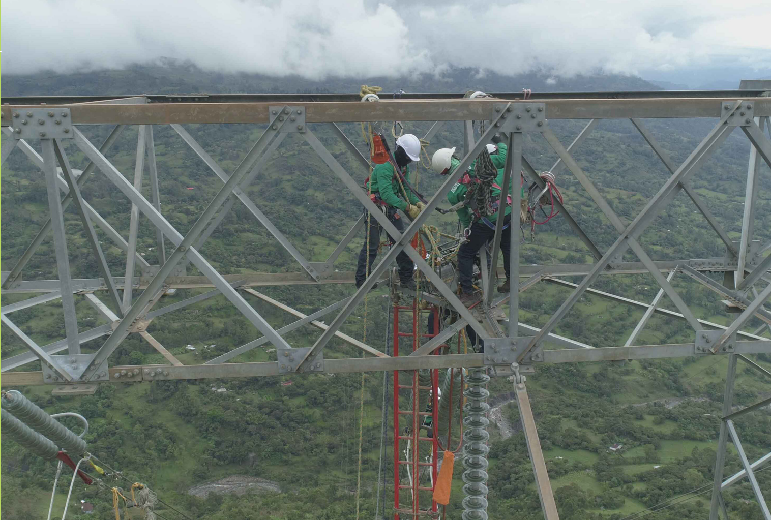
En promedio ocho horas diarias puede durar la jornada de un liniero en las alturas durante el mantenimiento de las líneas de transmisión de transmisión, jornada de mantenimiento en la torre 77 de la línea Guavio, Circo
