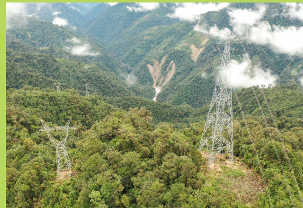
Después de arduas jornadas se levantó la torre que permite que al sur del país le llegue el servicio de energía eléctrica
