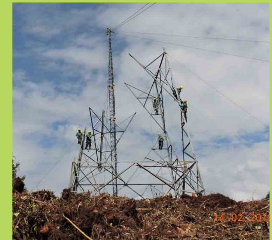
Jornada de construcción de la torre 309, segundo tramo proyecto Tesalia - Alférez en Pradera, Valle del Cauca
