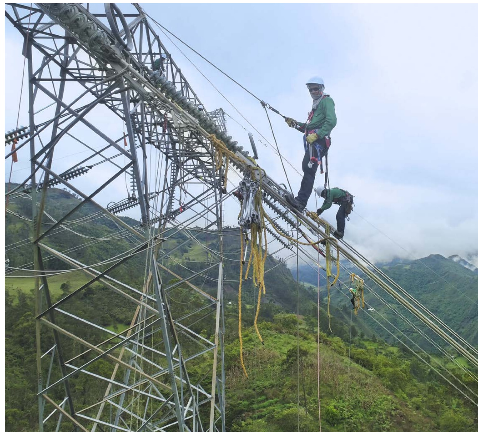
Mantenimiento de líneas de transmisión Circo-Guavio, torre 77
