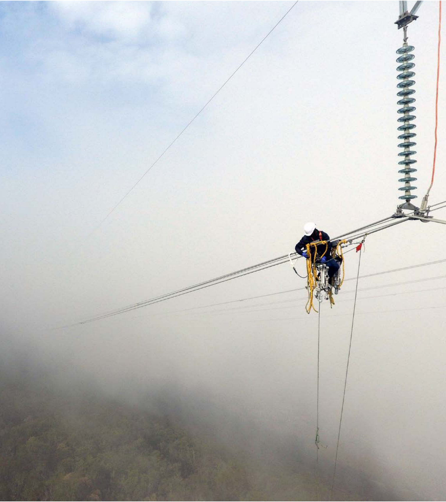
Mantenimiento línea de transmisión en Guasca, Cundinamarca
