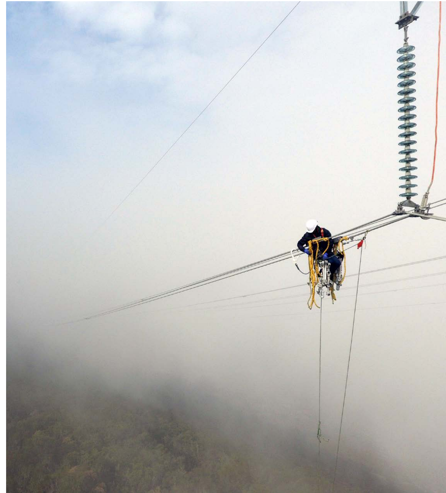
Mantenimiento línea de transmisión en Guasca, Cundinamarca
