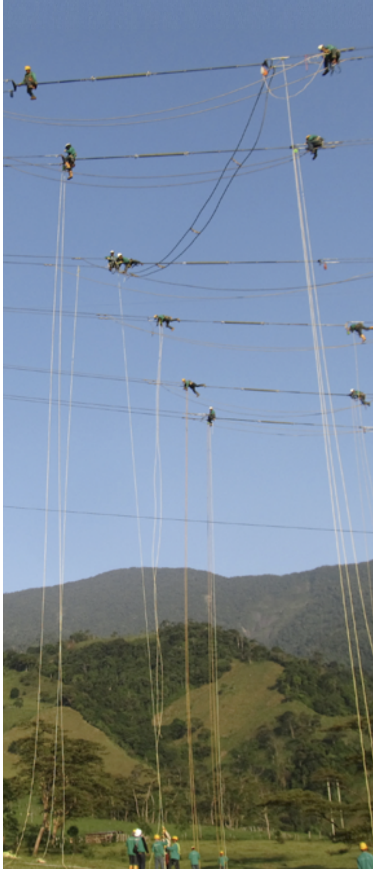
Mantenimiento de la línea Guavio-La Reforma, en Medina, Cundinamarca. Nuestra cuadrilla de linieros realiza la labor a 50 metros de altura con todas las normas de Seguridad y Salud en el Trabajo
