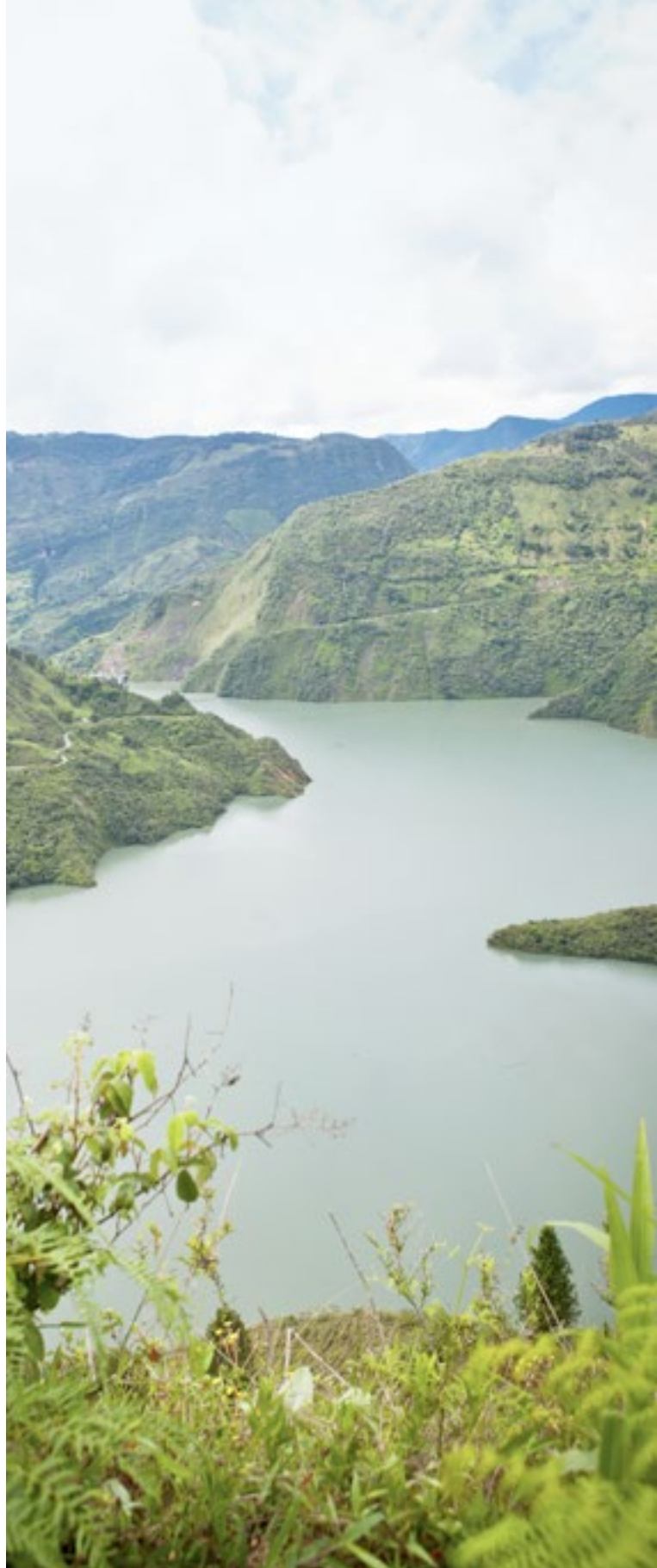
Embalse del Guavio, que alimenta la central hidroeléctrica del mismo nombre. Proyecto del Grupo Energía Bogotá en Cundinamarca
