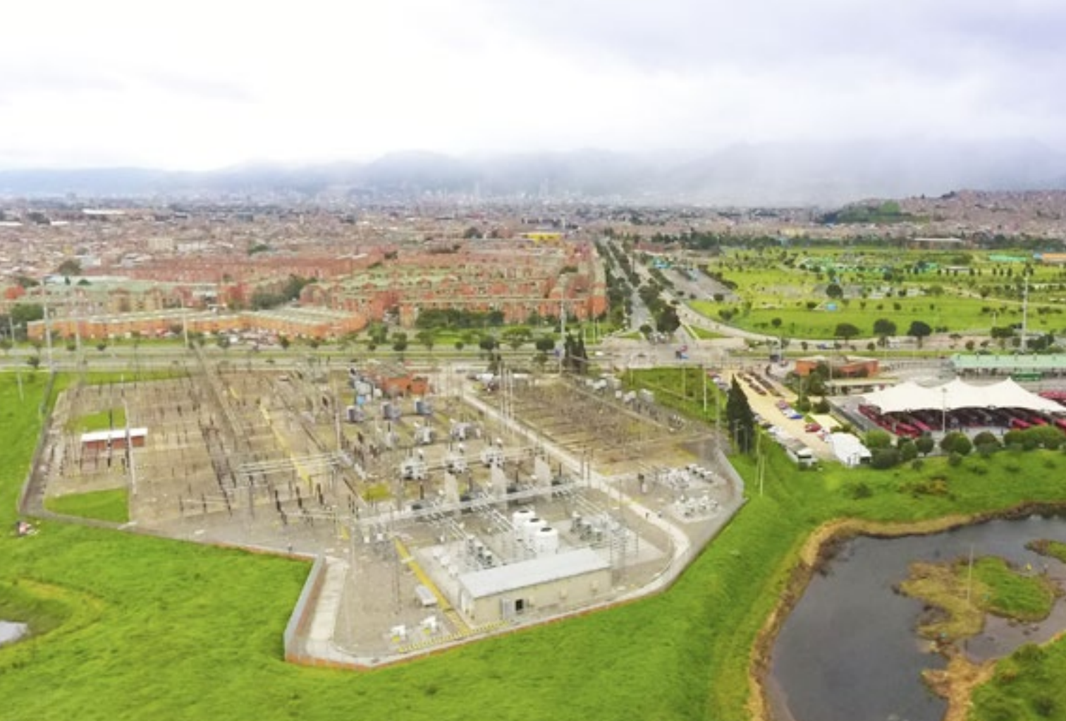
Subestación Tunal, con la que abastecemos de energía a Bogotá
