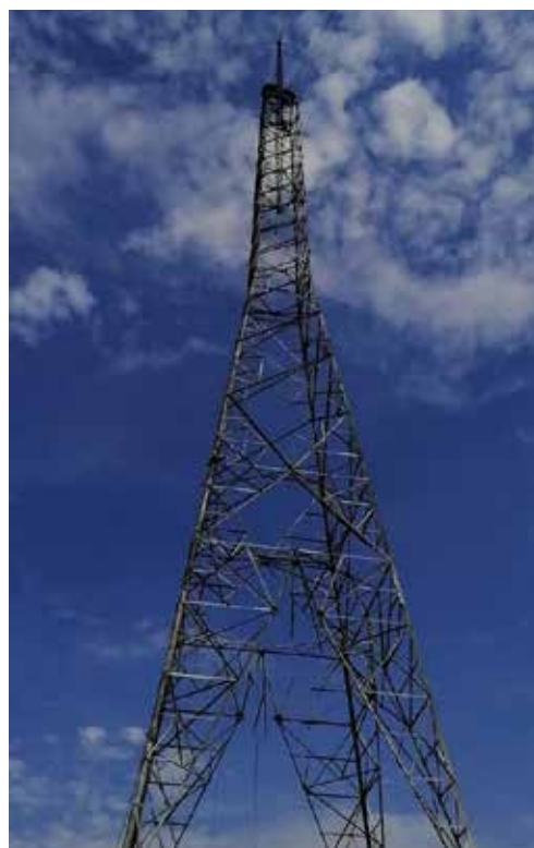
Montaje de tramo 3 Alférez - San Marcos
