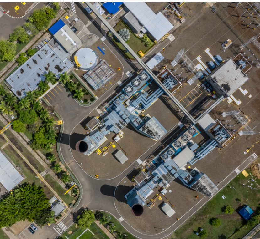
Subestación Termocandelaria. Cartagena.
