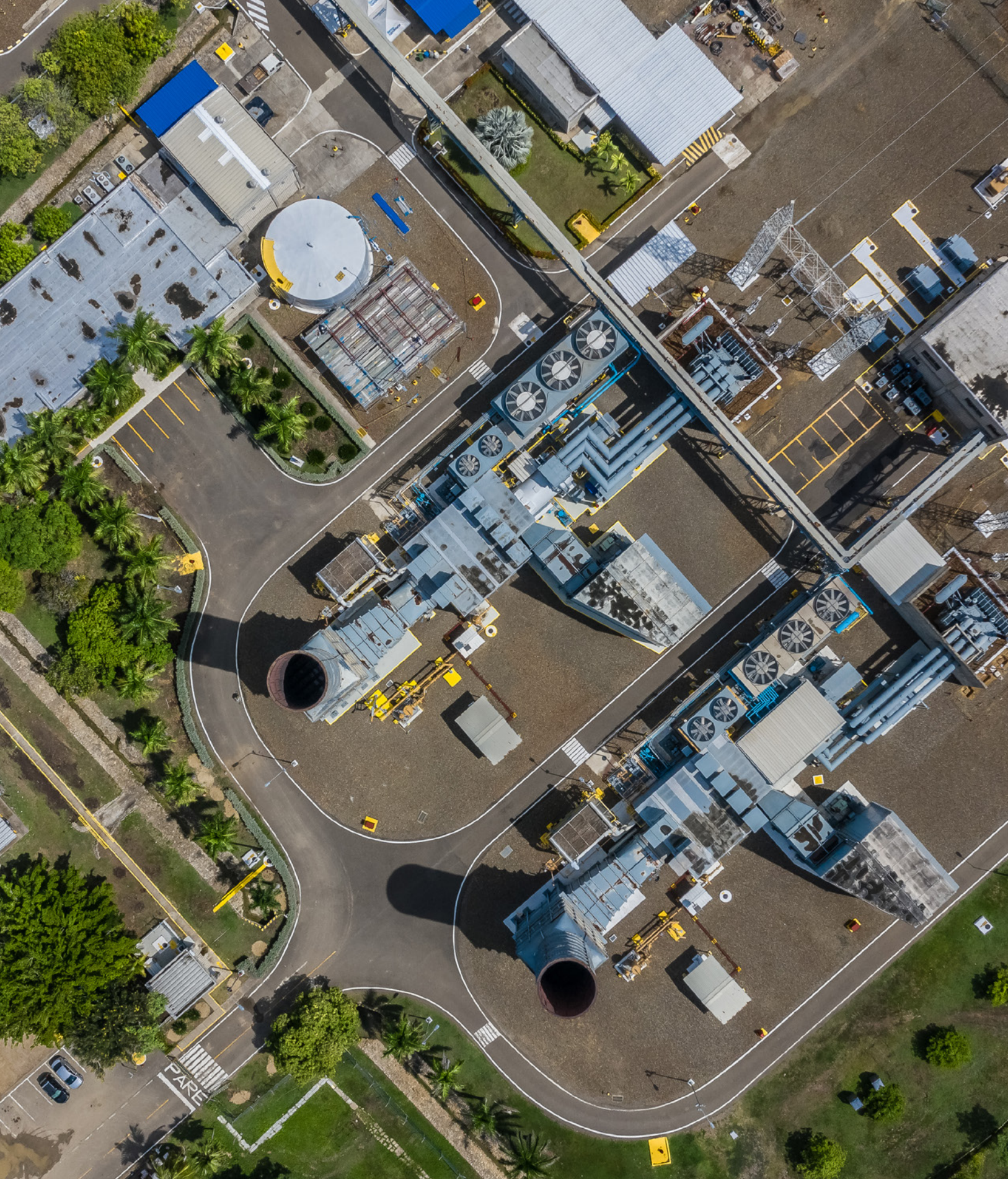
Subestación Termocandelaria. Cartagena.
