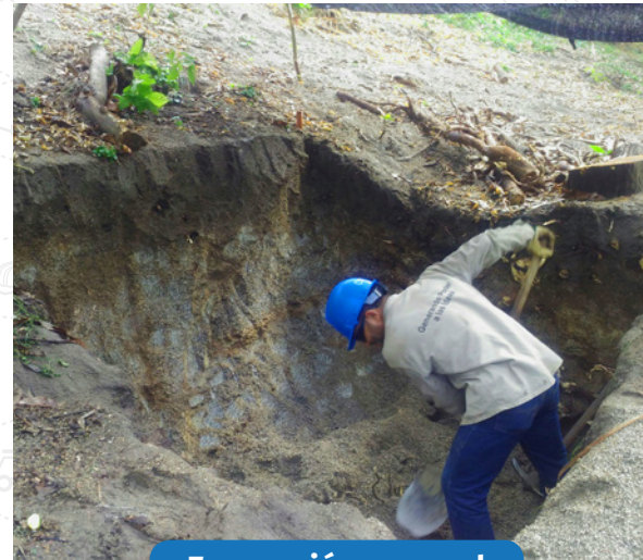
Excavación manual
