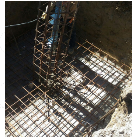
Armado de hierro de zapata
