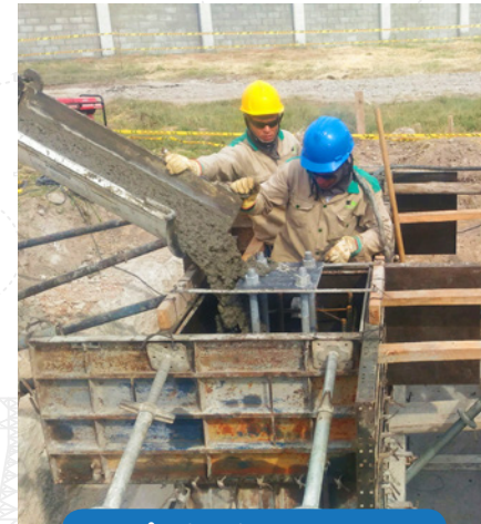
Vaciado de concreto
