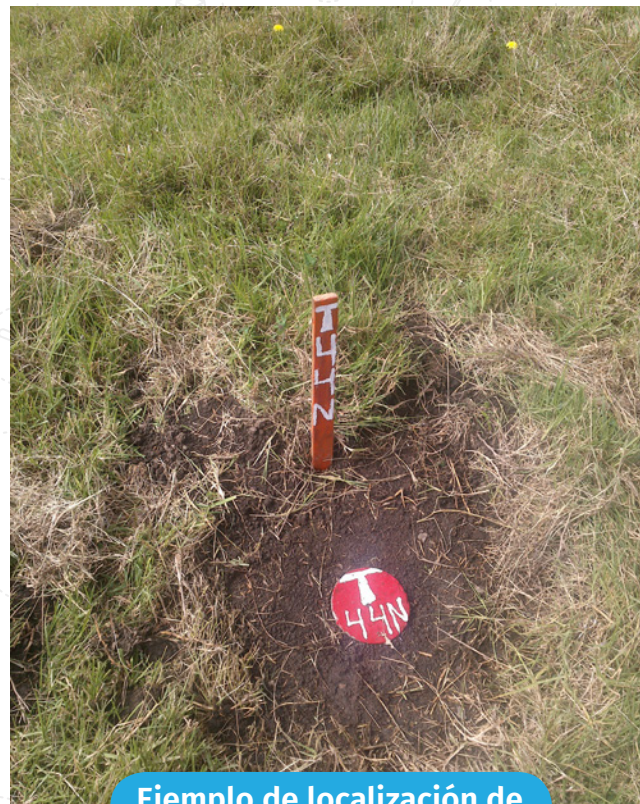
Ejemplo de localización de sitio de torre en campo
