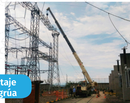
Montaje con pluma de izaje
