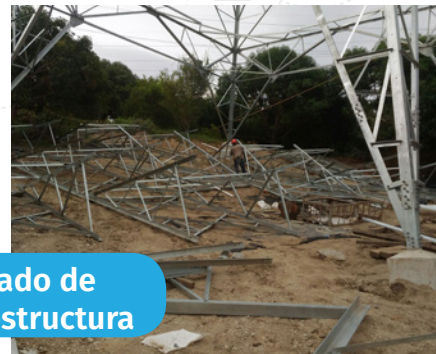
Movilización de estructura a sitio de montaje
