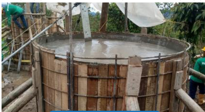
Vaciado de concreto
